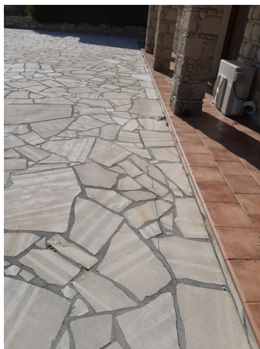
Εικόνα 48. Αποψη ρωγμών σε δομικά στοιχεία του κτιρίου B της ανωτέρω εικόνας.
