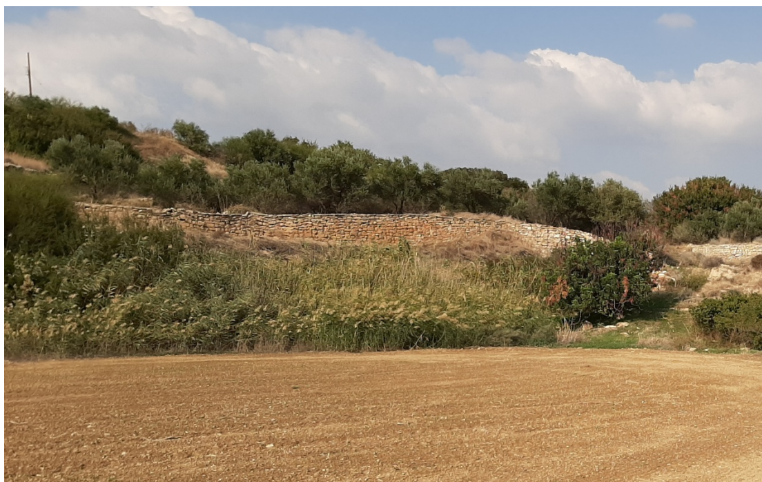
Εικόνα 26. Θέση στο ΝΑ τμήμα της κατολισθαίνουσας μάζας που εκδηλώνεται επιφανειακή ανάβλυση του υπόγειου υδροφόρου.
