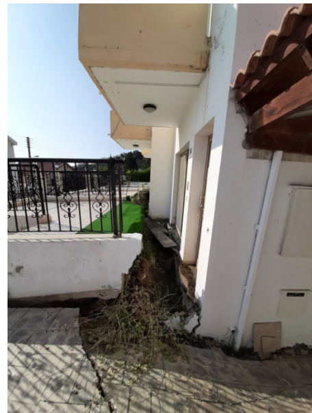
Εικόνα 45. Η οικία A που έχει εκτραπεί από την κατακόρυφη θέση εξαιτίας της ανάπτυξης του ποδιού της αβαθούς κατολίσθησης κάτω από την επιφάνεια θεμελίωσής της.
