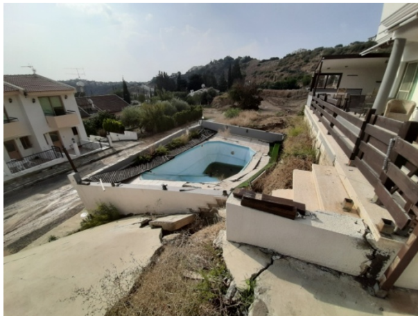
Εικόνα 44. Άποψη της κύριας κατακρήμνισης της κατολίσθησης που διέρχεται μπροστά από την οικία B και έχει μετατοπίσει την πισίνα.
